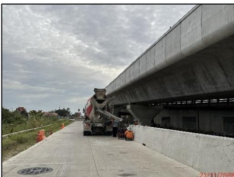
การเท Concrete Barrier บริเวณจุดกลับรถใต้สะพานสะพาน ข้ามแม่น้ำเจ้าพระยา ฝั่ง จ.พระนครศรีอยุธยา
